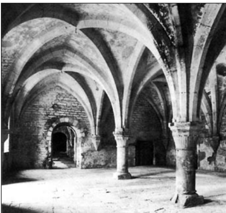
Unter diesem Gewölbe der Abtei von Fontenay befand sich vermutlich die Schmiede des Klosters.
